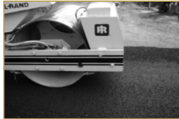
Figura 3.- Ilustración de compactación de una mezcla asfáltica.
