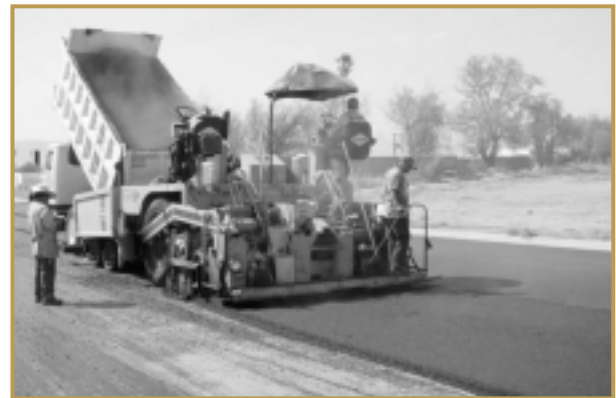
Figura 2.- Ilustración del extendido de una mezcla asfáltica.
