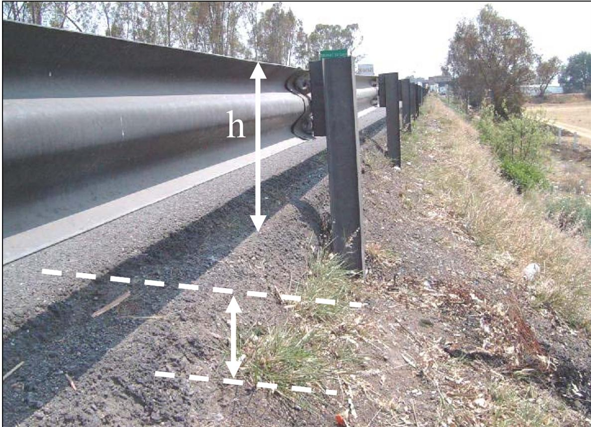
**Figura 14. Altura inadecuada de la barrera**
