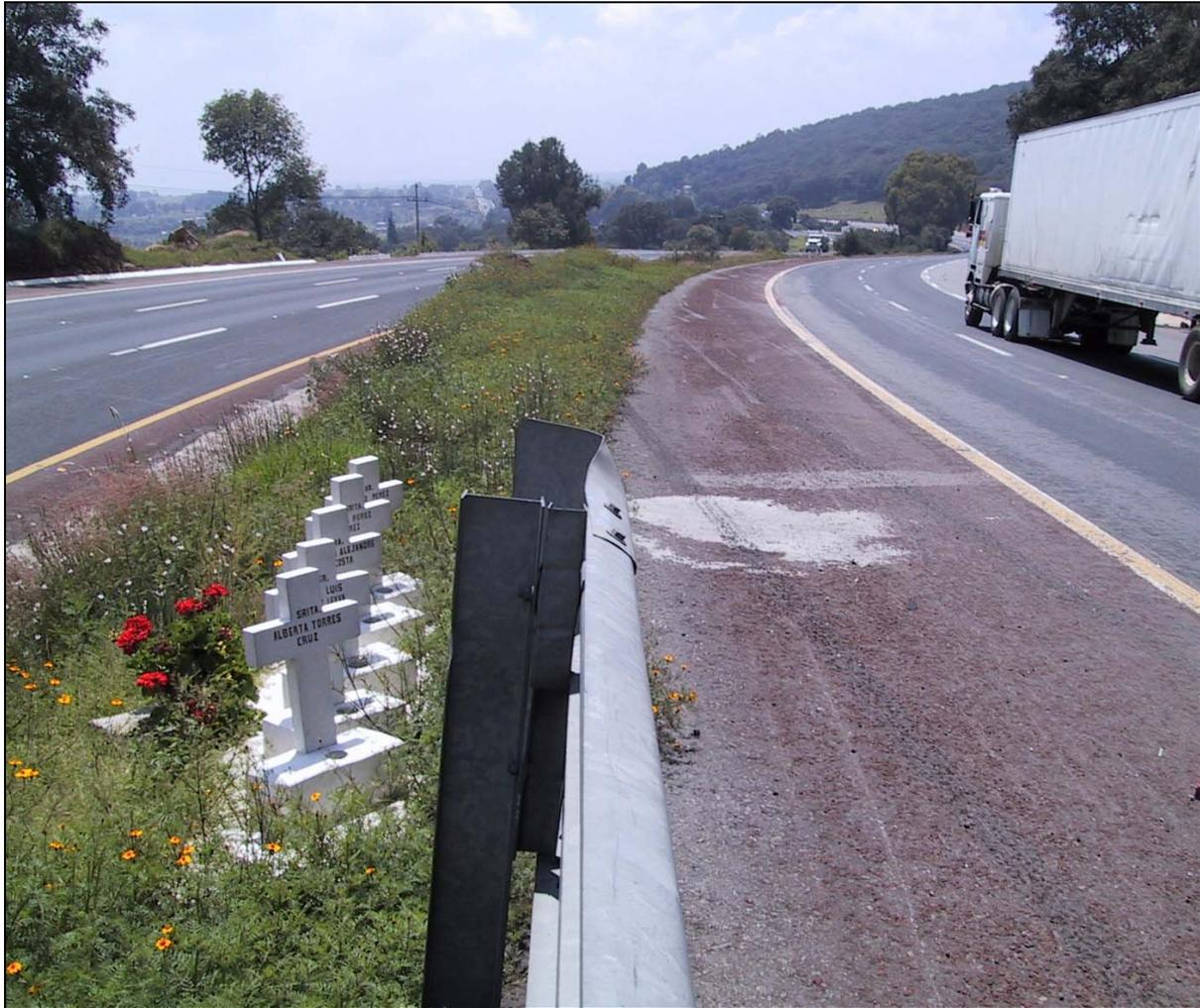
**Figura 7. Falta de continuidad de una barrera metálica en una curva**
