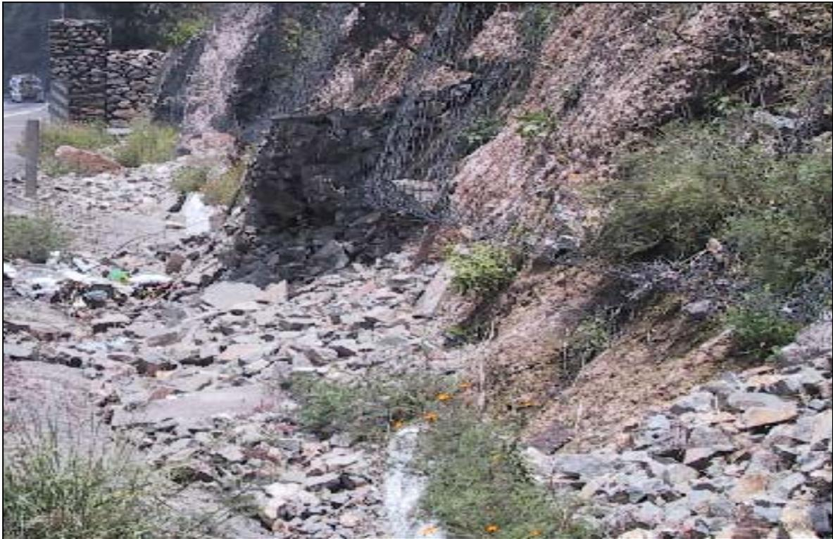
**Figura 6. Azolve de una cuneta por derrumbes**
