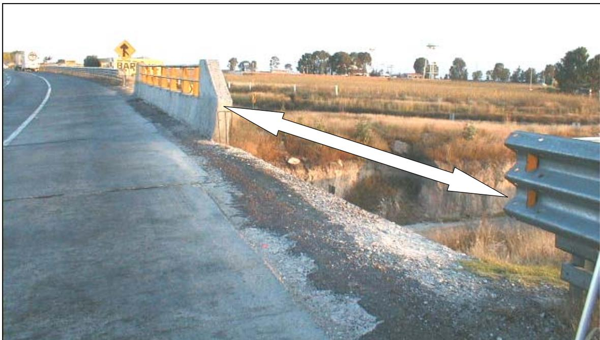
**Figura 13. Falta de un elemento de transición entre la barrera metálica y el puente**
