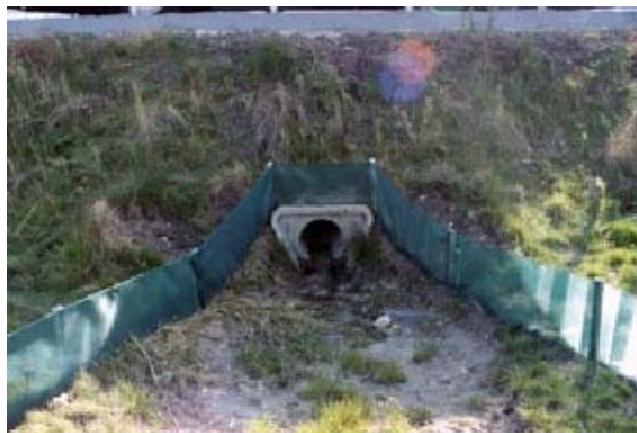
Figura 4. Obras de drenaje
