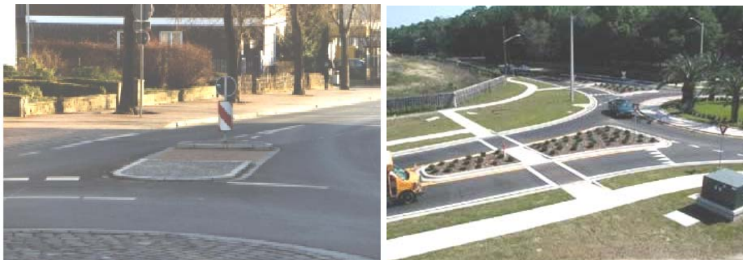
Encauzador vehicular con rebaje peatonal
