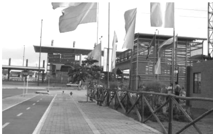
Imagen 3. Finalización del Tramo III Frente a la Estación Banderas
