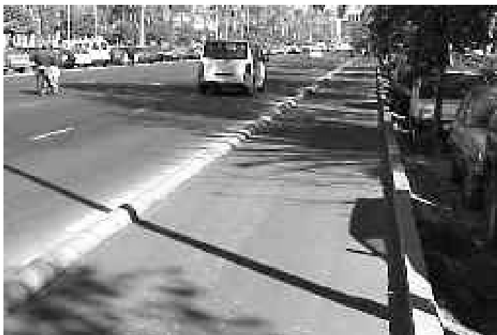
Foto 3: Carril bici segregado.
