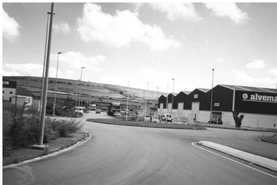
Foto 5: Ausencia de balizamiento y cartel de advertencia en la rotonda.
