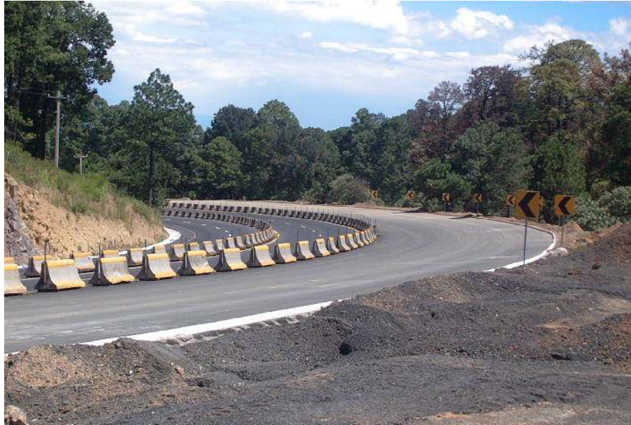
Figura 6. Fotografía de la segunda curva, durante la realización de los trabajos de mejoramiento
