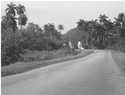
(F-15) Ausencia de Defensas
