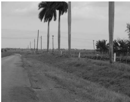
(F-17) Afectación en borde y pérdida de paseos
