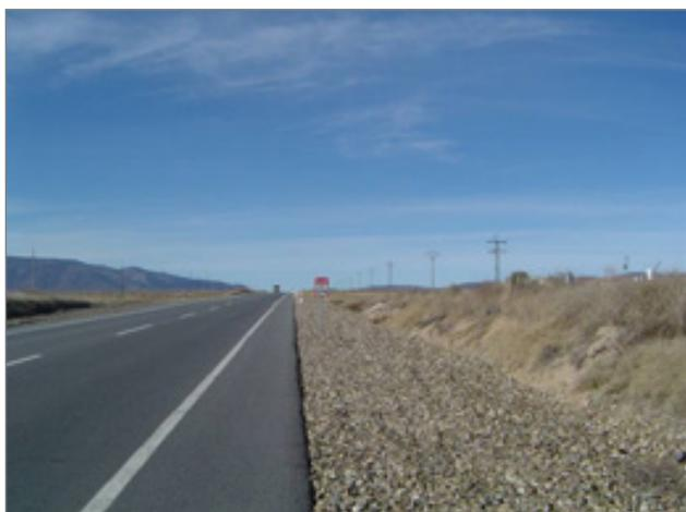
**Foto 1.** Carretera N-110, p.k. 256. Relleno de cuneta profunda con material drenante.
